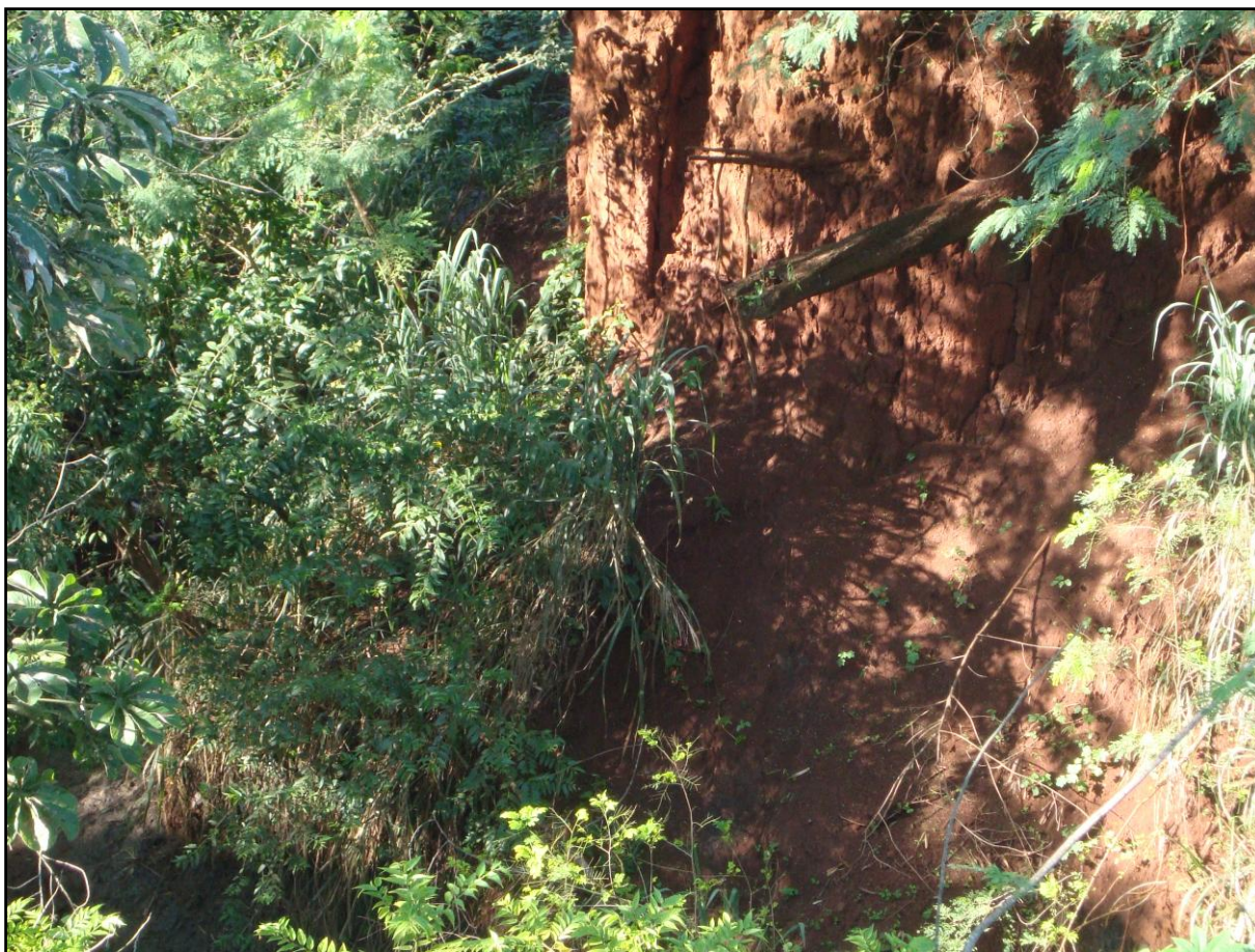
FIGURA 6: Vincos verticais desde o topo até a base da margem. Ponto P1.
